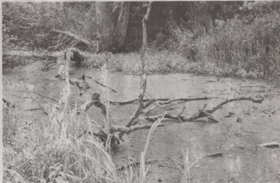
Aktuelle Untersuchungen haben ergeben, dass lediglich rund 41 000 Kubikmeter Schlamm aus dem Nordkanal zu entsorgen sind. Vorher war davon ausgegangen worden, dass es rund 55 000 Kubikmeter sind. NGZ-FOTO: M. REUTER
