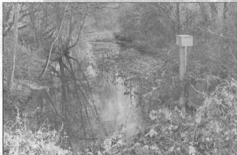
Schlamm und Morast im Nordkanal – oft sind die Massen schon mit bloßem Auge zu erkennen.
